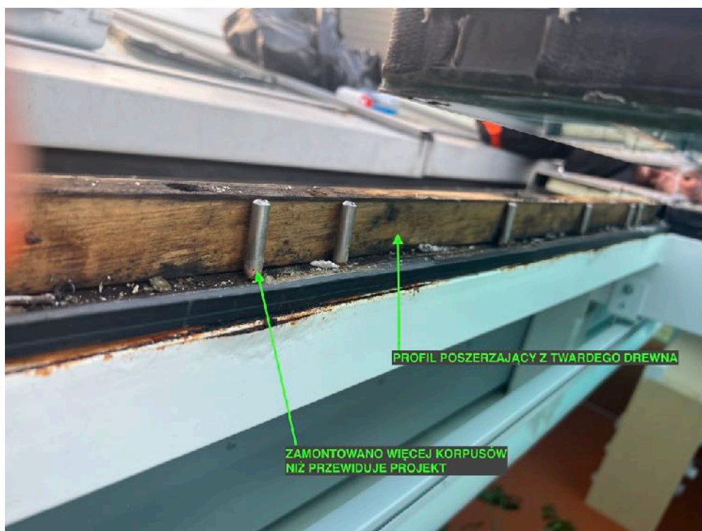
14. Na płatwi zamontowano dodatkowe korpusy. W wyniku wielokrotnego przebicia uszczelki, woda ma więcej miejsc do wciekania w miejsca chronione przed wilgocią.
