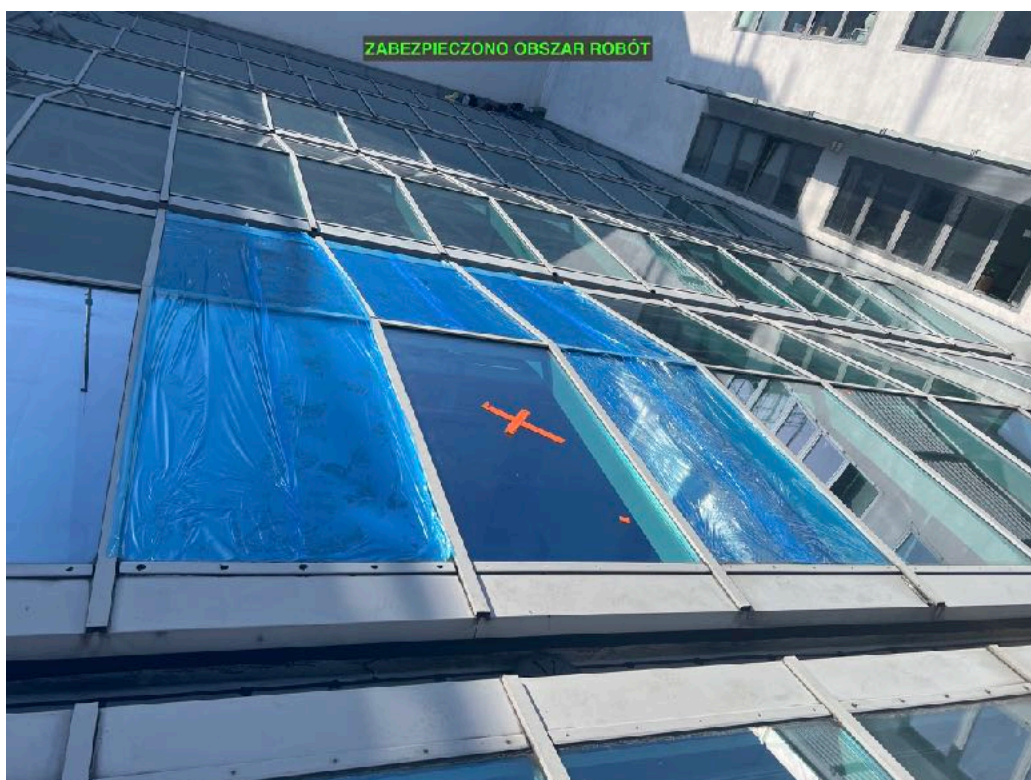
2. Miejsce odkrywki zabezpieczono folią.
