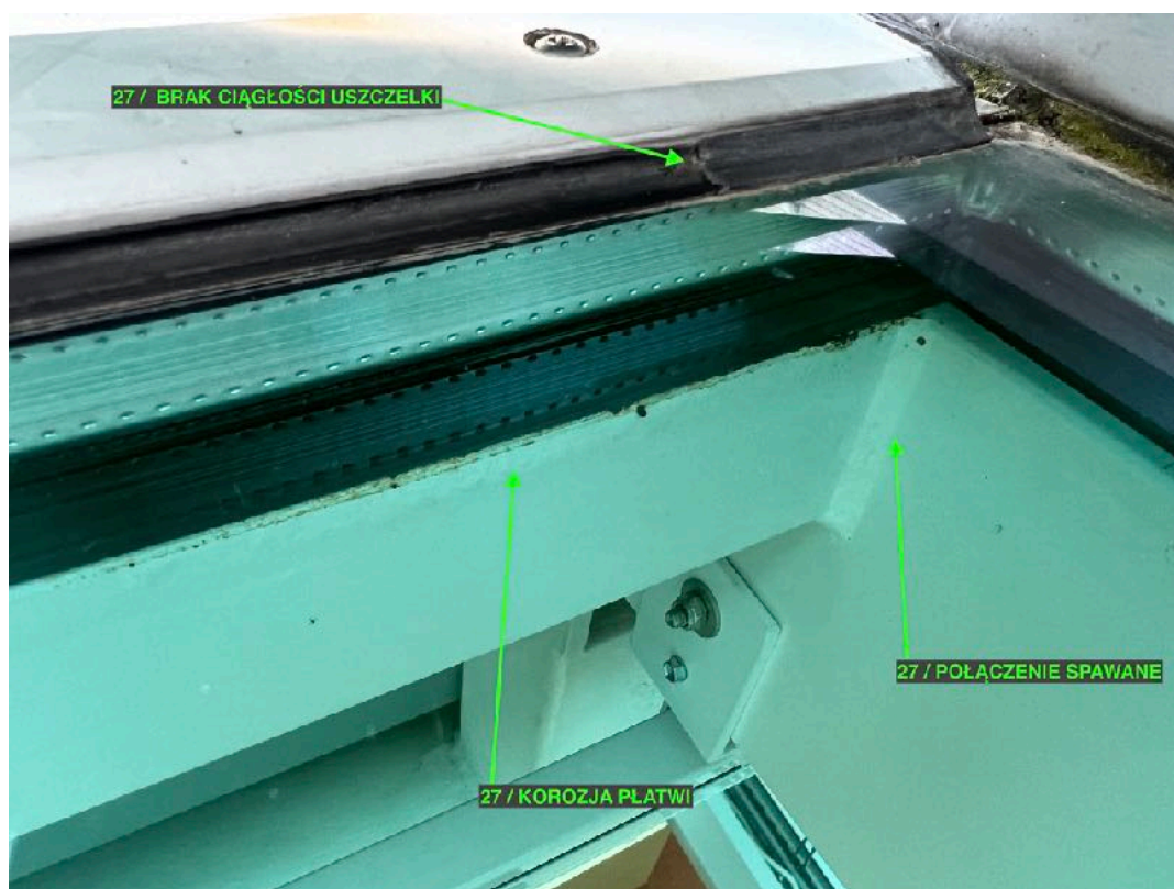
27. Korozja profilu płatwi. Brak ciągłości uszczelki pod dociskiem.
