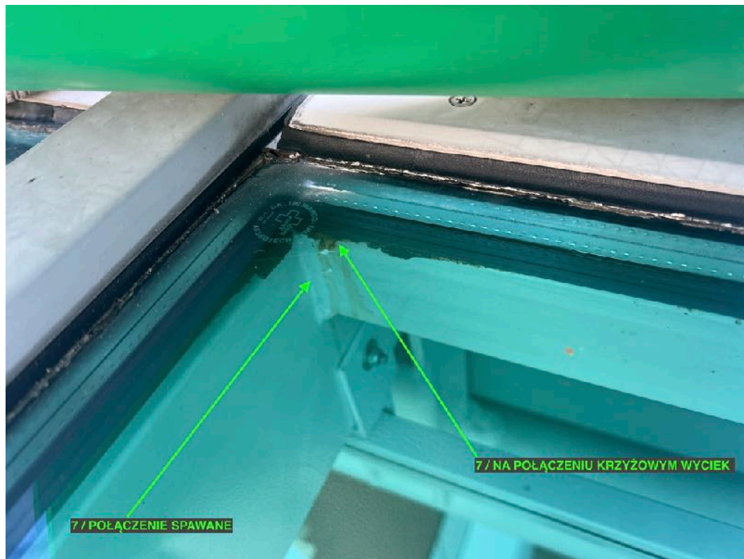
7. Na połączeniu krzyżowym brudny wyciek.
