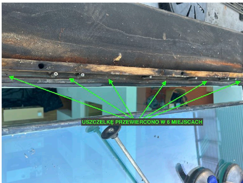
23. Uszczelkę płatwi przewiercono w 6 miejscach. Taka sytuacja zdarza się, gdy nie zostaną zachowane dystanse przy wierceniu otworów w kątowniku podparcia.
