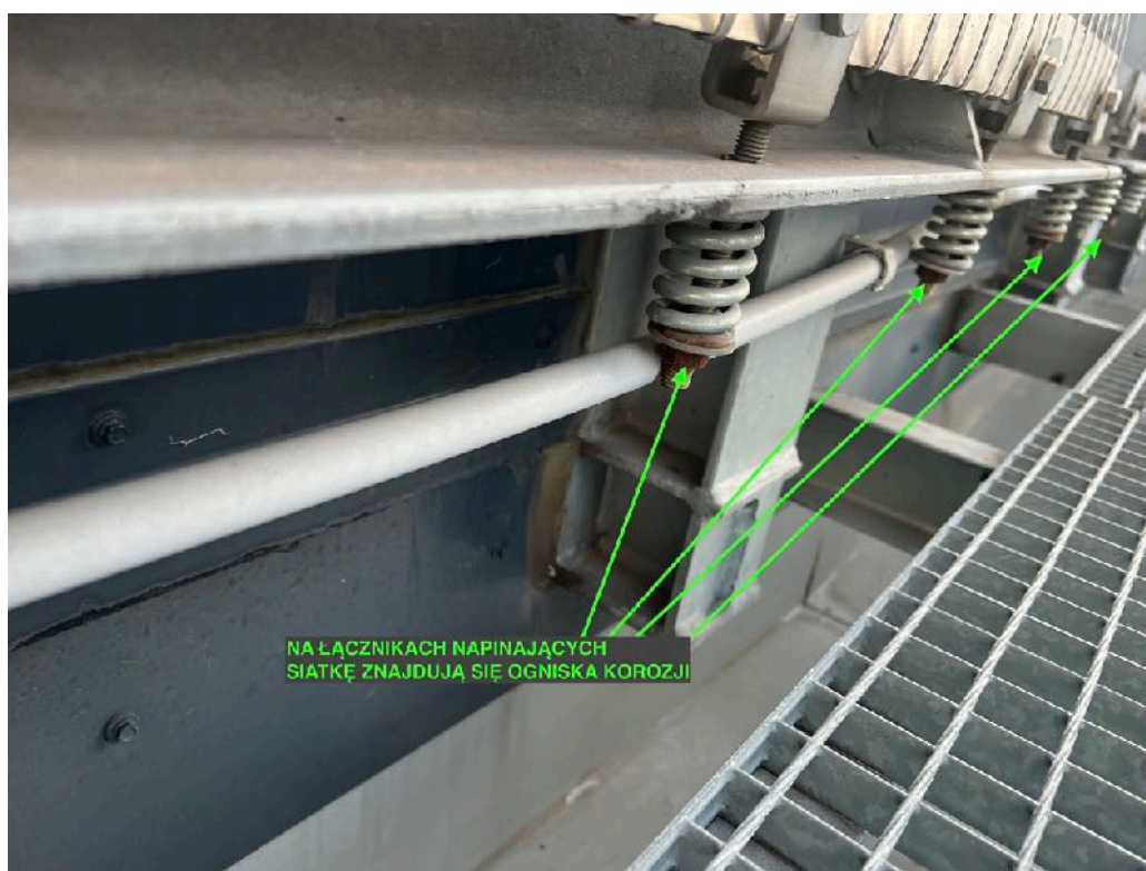
3. Na łącznikach napinających siatkę stalową znajdują się ogniska korozji.
