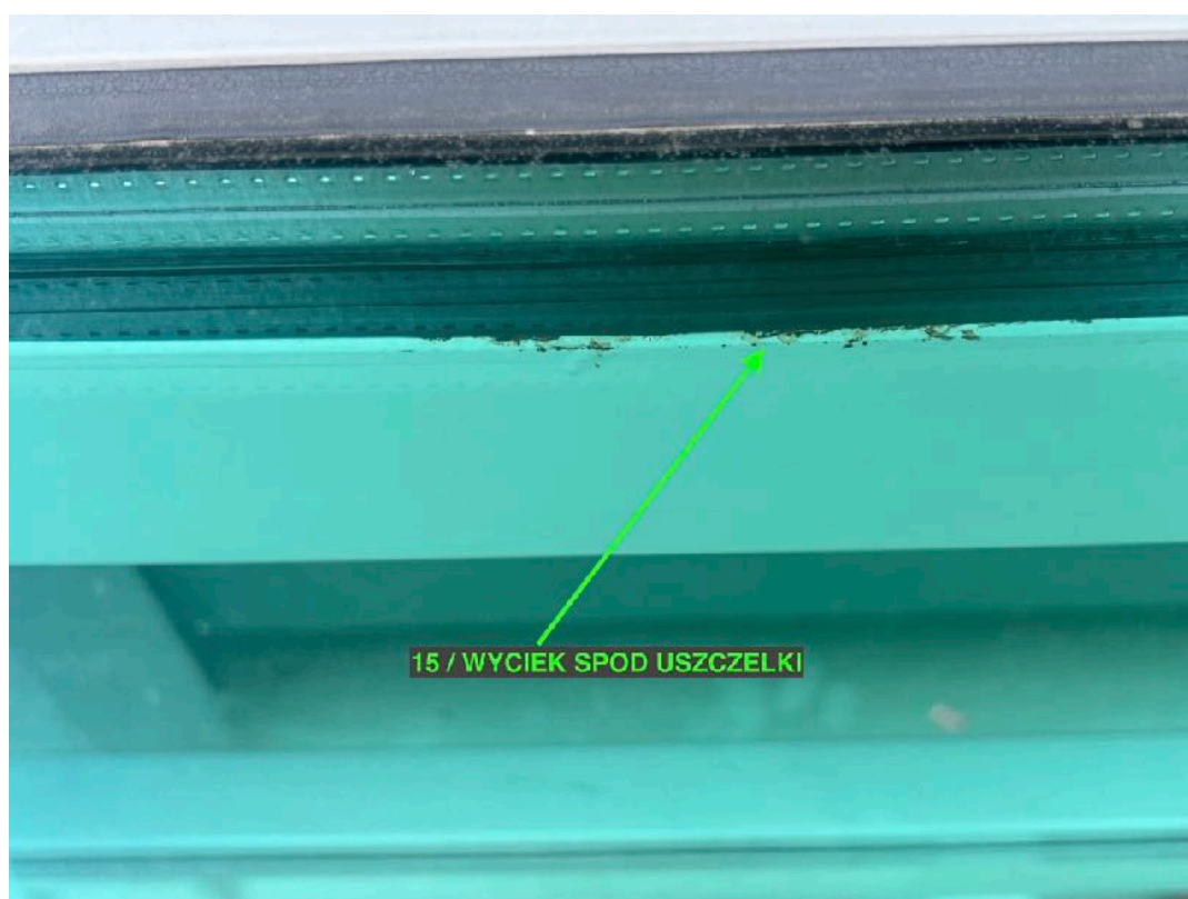
15. Brudne wycieki na połączeniu krzyżowym i pod uszczelką płatwi. Brak ciągłości uszczelki pod dociskiem.
