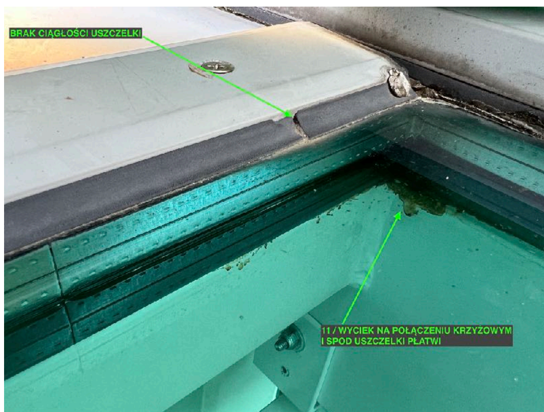
11. Brudny wyciek spod uszczelki na połączeniu krzyżowym. Brak ciągłości uszczelki pod dociskiem.
