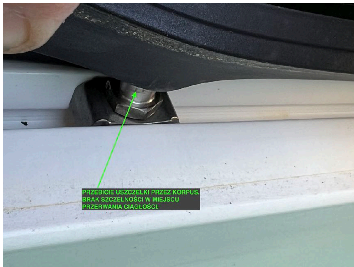
26. W miejscu przebicia uszczelki przez korpus brak szczelności.
