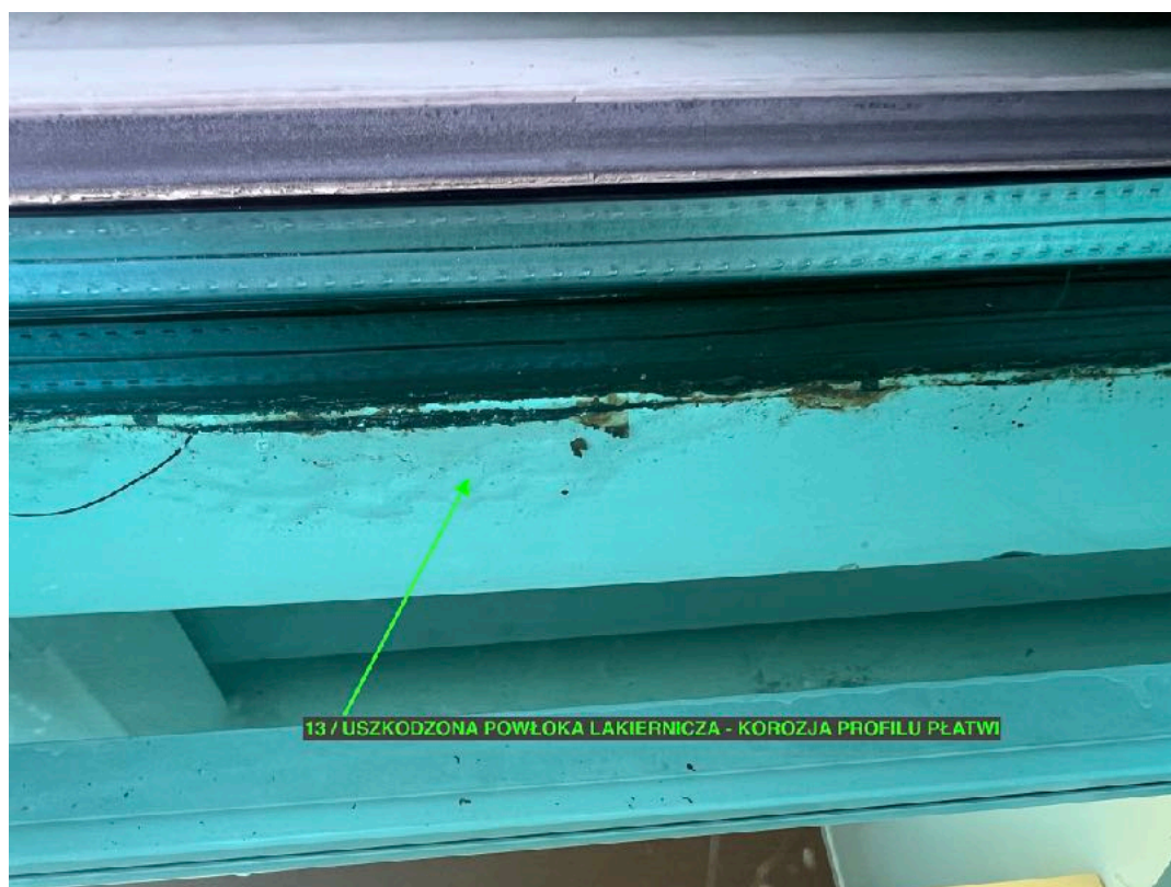
13. Wycieki spod uszczelki. Uszkodzona powłoka lakiernicza. Na profilu płatwi zaawansowana korozja.
