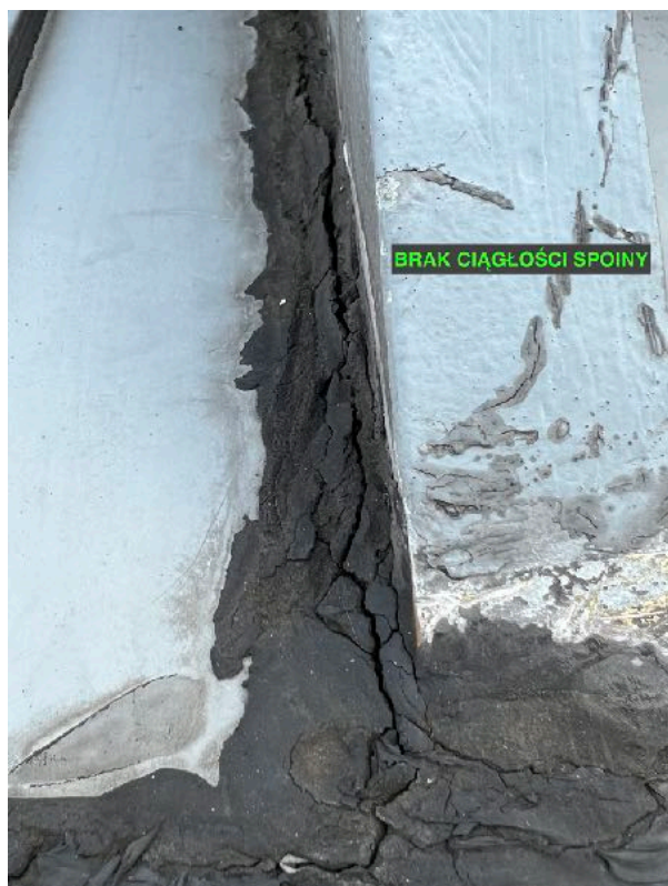
5. Odciąg nr 5: brak ciągłości silikonowej spoiny na połączeniu uchwyty z obróbkami blacharskimi. Odpryski powłoki lakierniczej.
