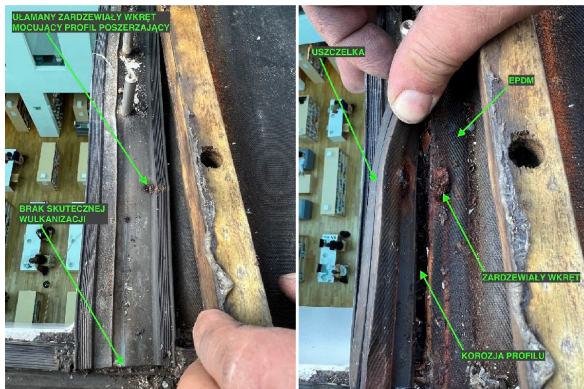
20. Na uszczelce - od strony krawędzi świetlika - pod profilem z drewna widać ułamany, skorodowany blachowkręt. W analizowanym przypadku, woda dostaje się do komory profilu.
