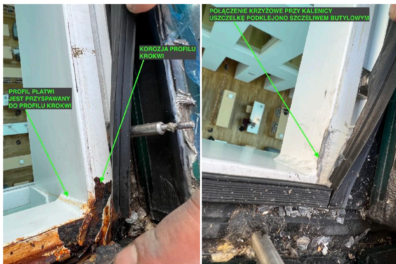
13. Korozja występuje na profilach włączeniu spawanym. Połączenie krzyżowe przy kalenicy jest słabo zwulkanizowane, pod uszczelką widoczne szczeliwo butylowe.
