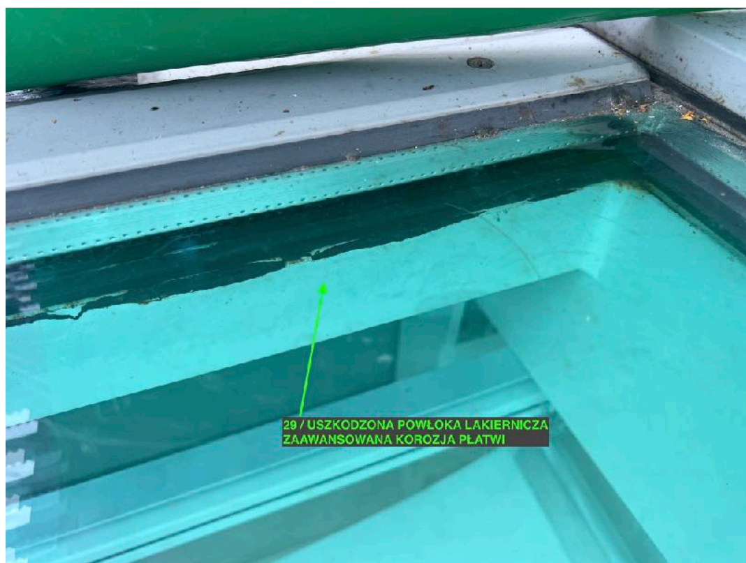
29. Uszkodzona powłoka lakiernicza. Zaawansowana korozja profilu płatwi.
