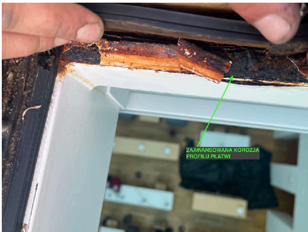
10. Zaawansowana korozja profilu płatwi.
