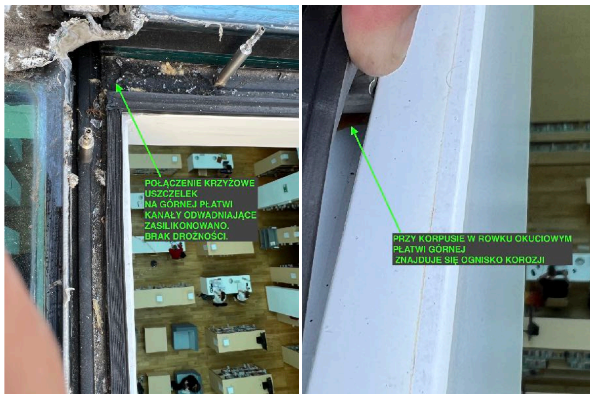
24. Płatwę górną. W uszczelce - na połączeniach krzyżowych - brak drożności kanałów wentylująco - odwadniających. Brak możliwości przepływu wody do kanałów w krokwi. Przy korpusie w rowku okuciowym widoczne ognisko korozji.
