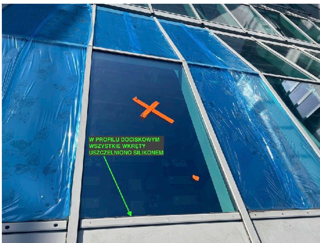
3. W profilu dociskowym płatwi wszystkie wkręty zasilikonowano szarym szczeliwem.
