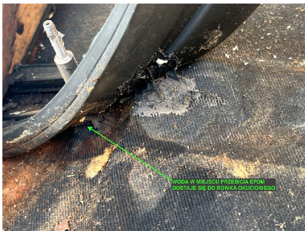
32. Woda w miejscu przebicia EPDM dostaje się do rowka okuciowego a następnie ścieka w izolację termiczną i na wewnętrzną obróbkę blacharską.
