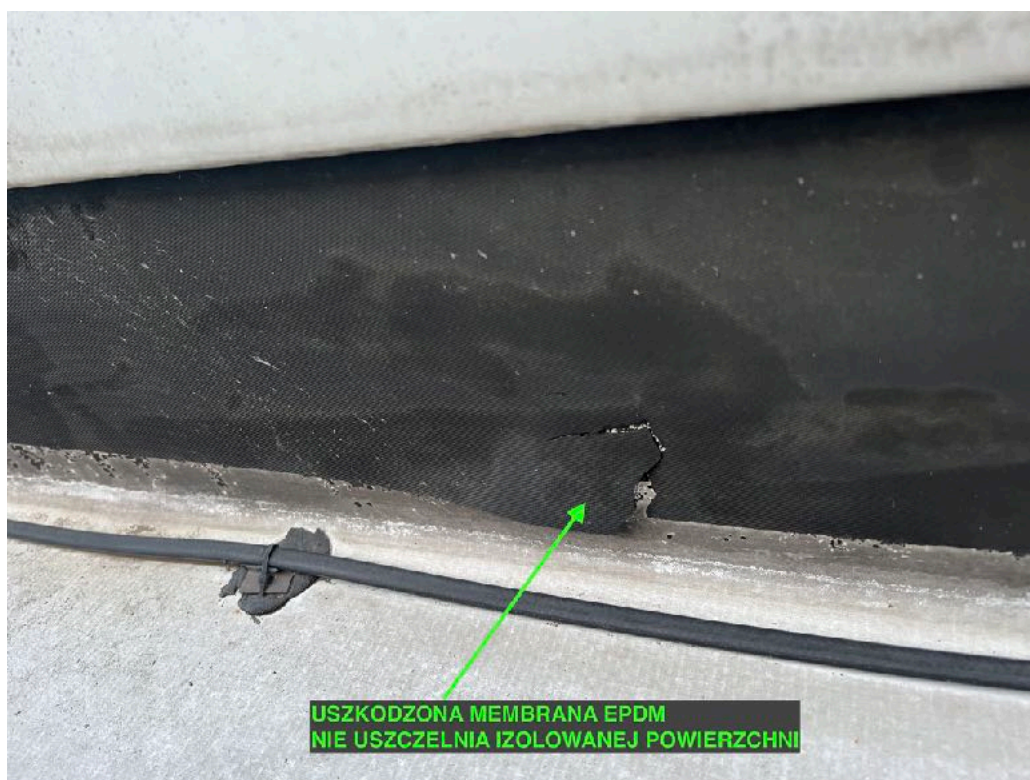
6. Na krawędzi uszkodzona membrana EPDM.
