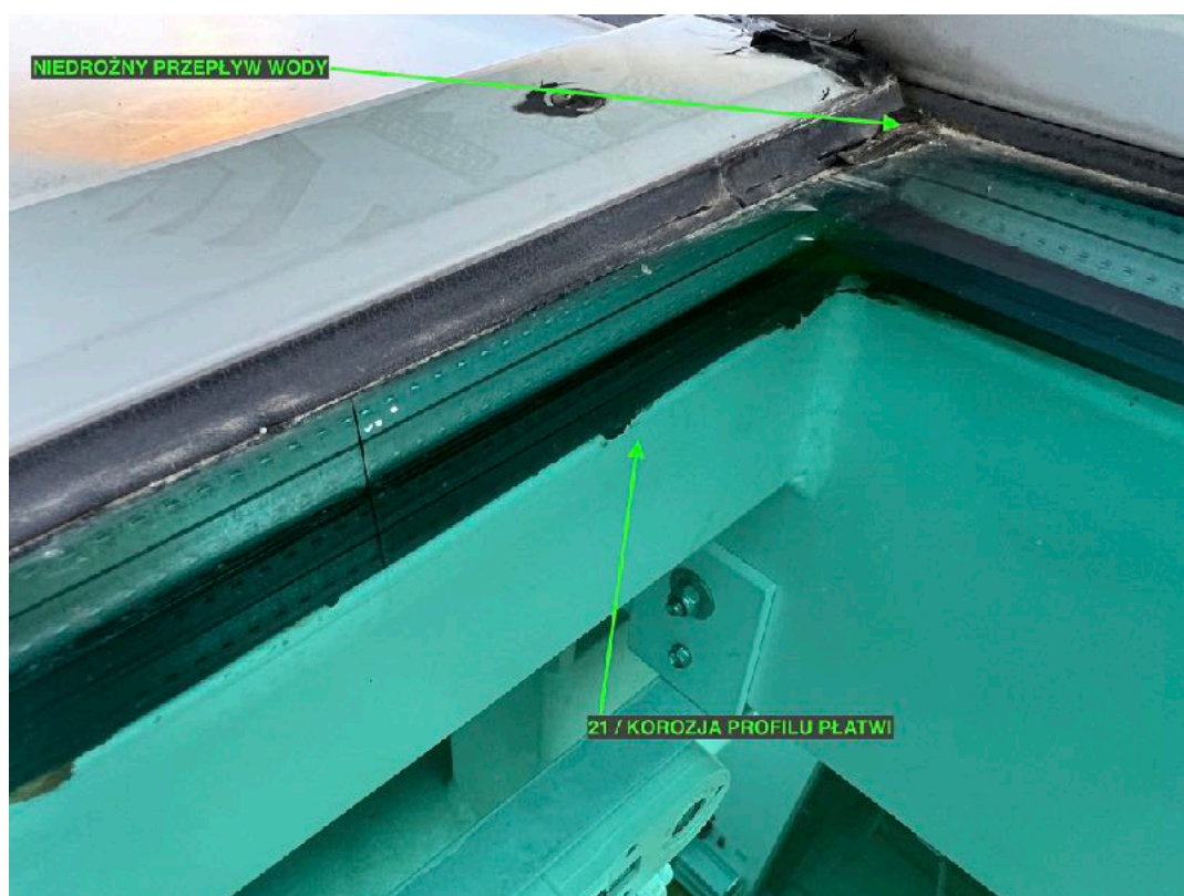
21. Zaawansowania korozja profilu płatwi. Niedrożny przepływ wody.
