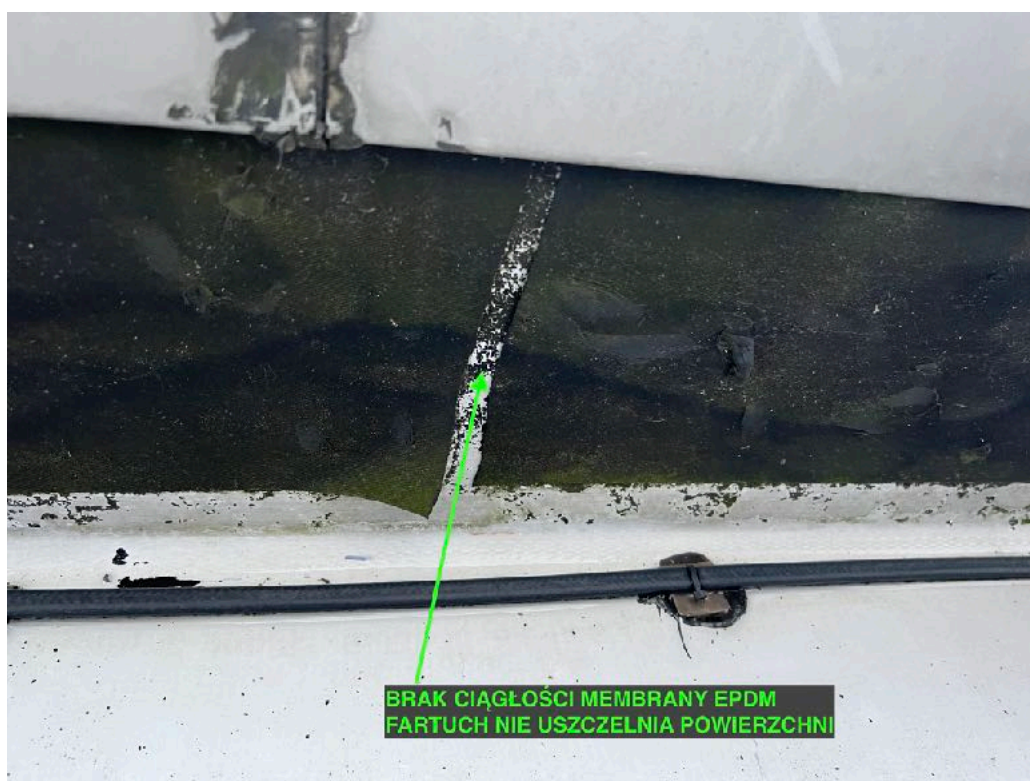
7. Brak ciągłości membrany EPDM. Fartuch nie uszczelnia izolowanej powierzchni.
