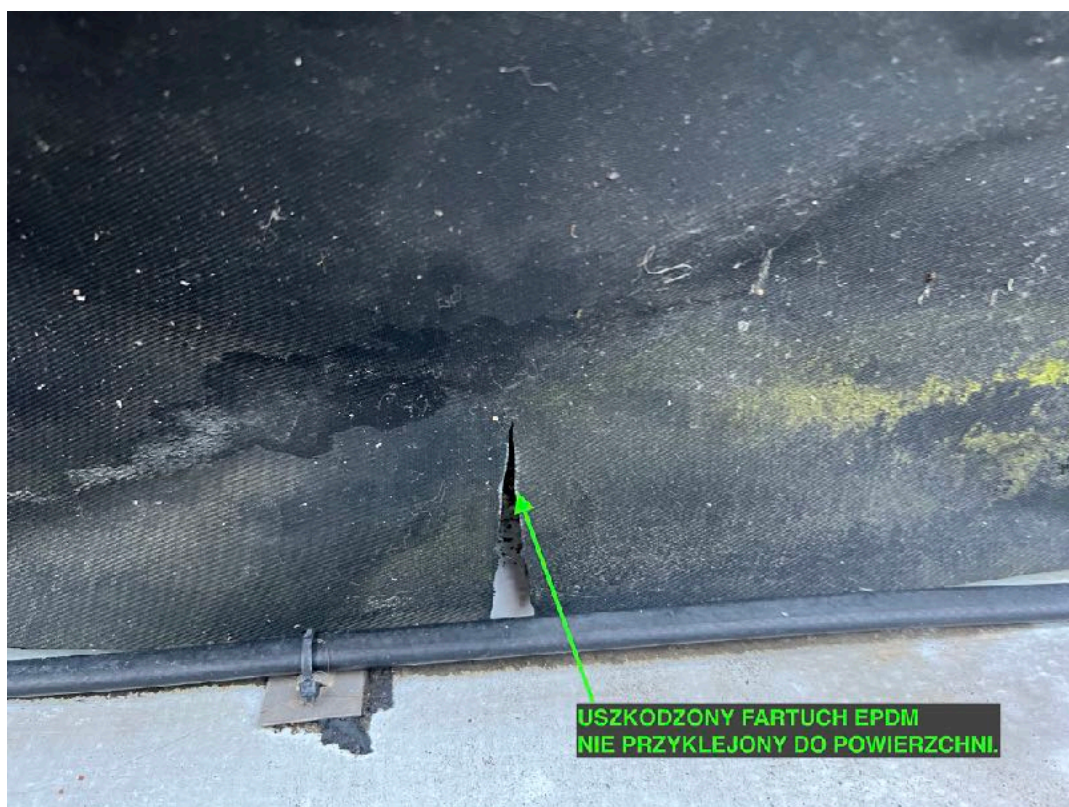
5. Na krawędzi uszkodzona membrana EPDM.
