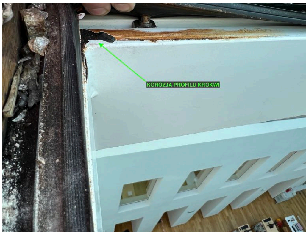
12. Na połączeniu krzyżowym korozja występuje na profilu krokwi.
