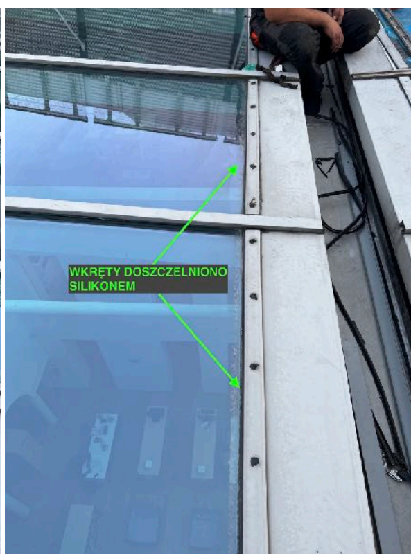
6. Na płatwiach dolnych w profilach dociskowych uszczelniono wkręty.
