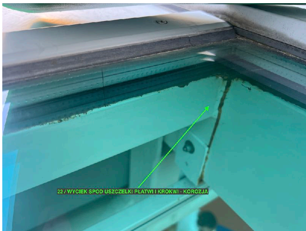
23. Korozja profilu krokwi i płatwi. Brudny wyciek spod uszczelki na połączeniu krzyżowym.
