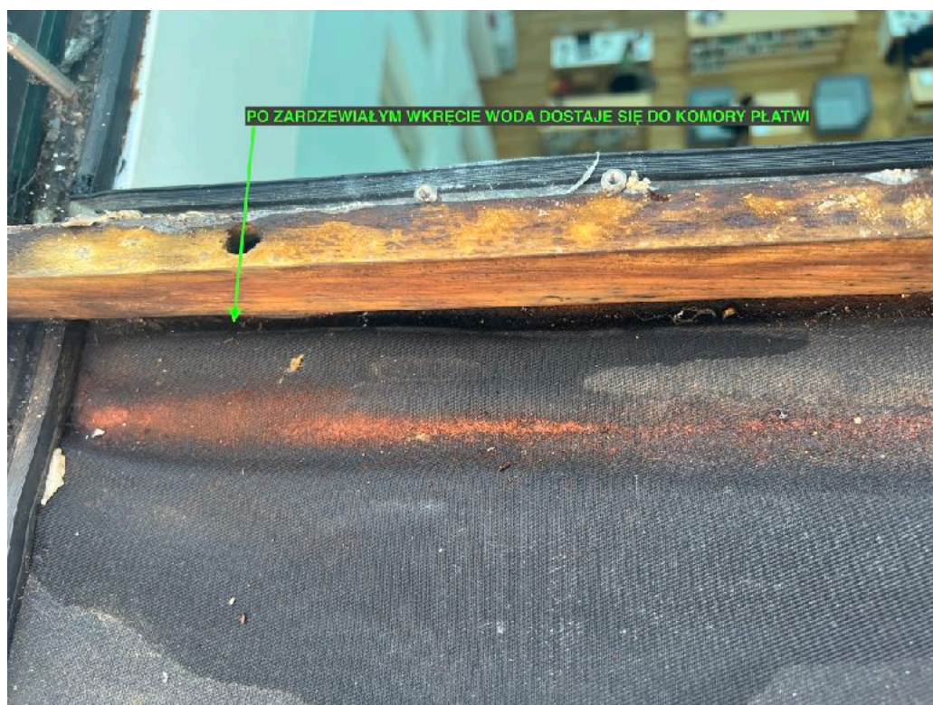
31. Po zardzewiałym wkręcie (wkrętach) woda dostaje się do zamkniętej komory płatwi.
