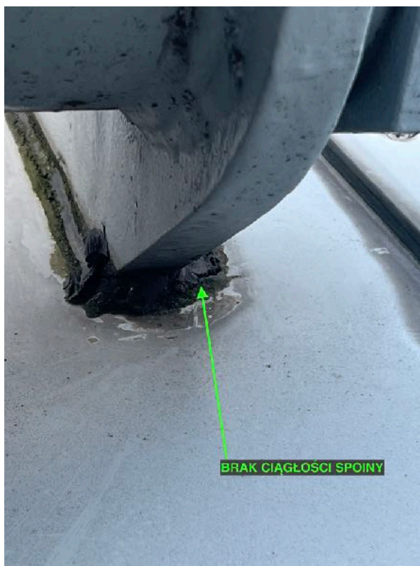
5. Odciąg nr 5: brak ciągłości silikonowej spoiny na połączeniu uchwyty z obróbkami blacharskimi. Odpryski powłoki lakierniczej.
