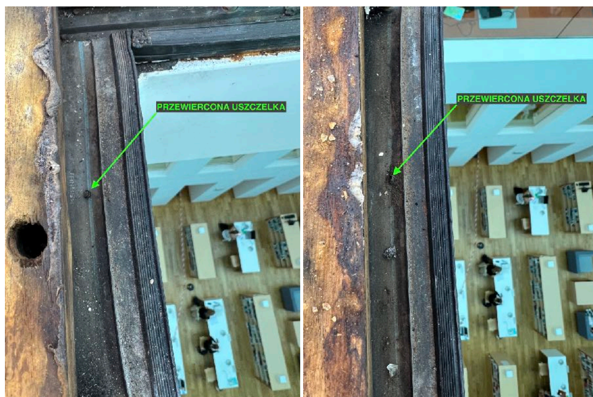
21. Przewiercona uszczelka na płatwi.
