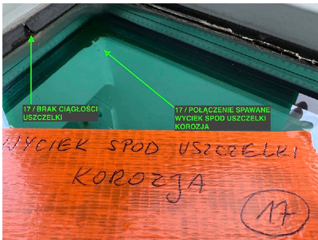
17. Wyciek spod uszczelki na połączeniu krzyżowym. Brak ciągłości uszczelki pod dociskiem.
