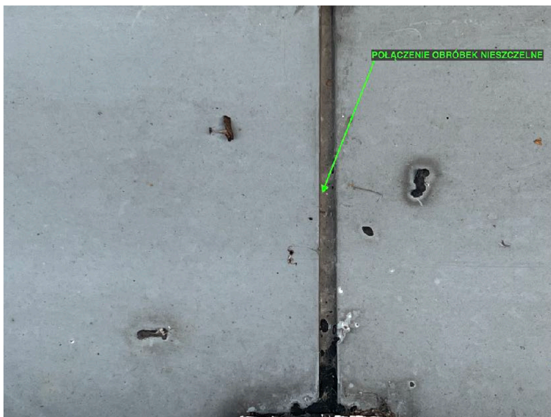
4. Brak szczelności na połączeniu obróbek blacharskich.
