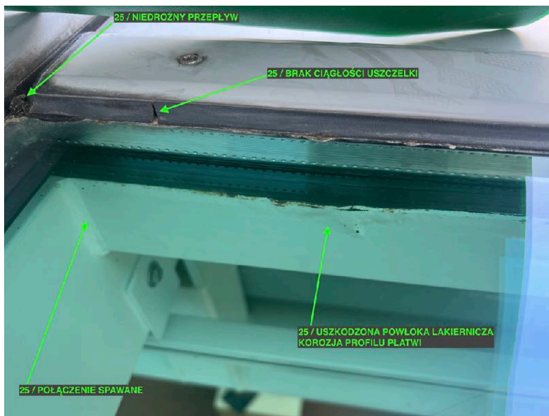
25. Uszkodzona powłoka lakiernicza - korozja profilu płatwi. Niedrożny przepływ wody. Brak ciągłości uszczelki pod dociskiem.
