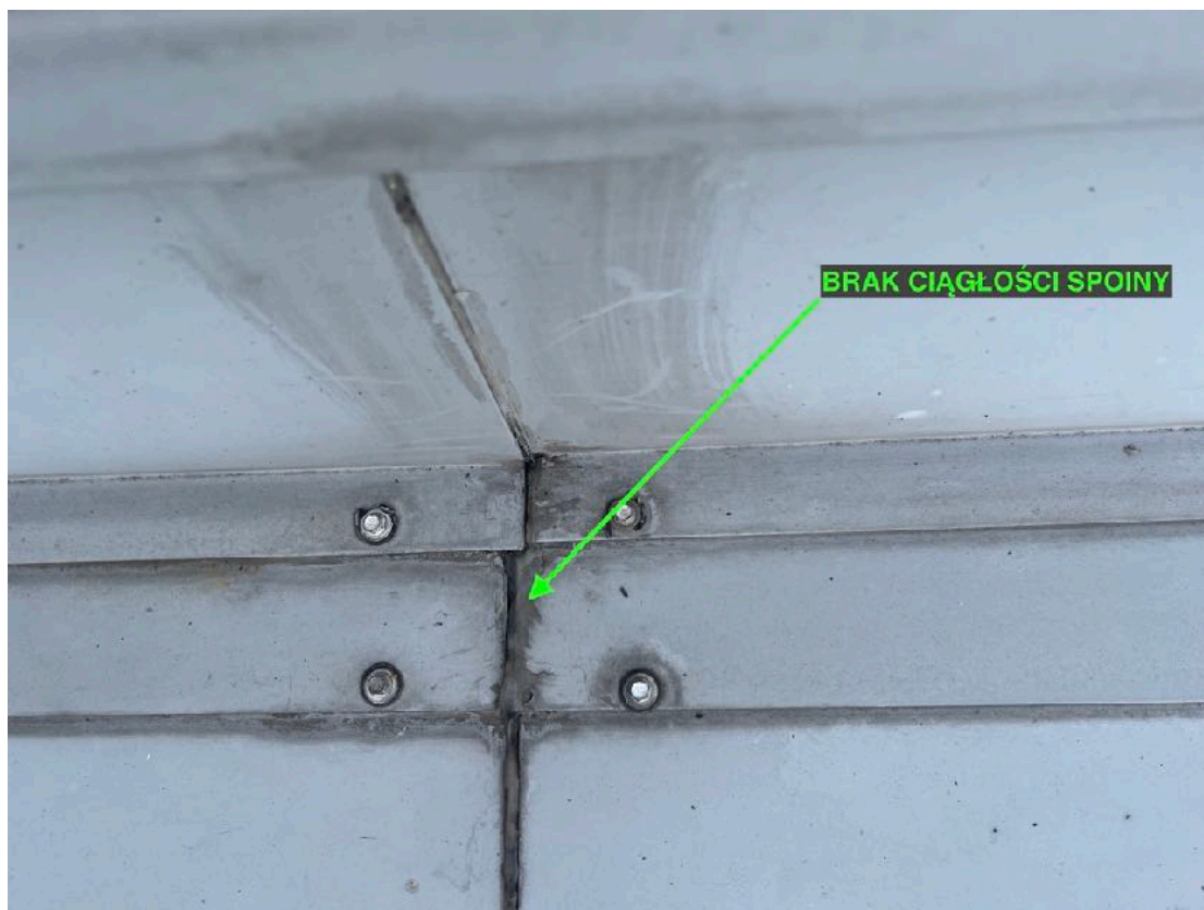
10. Brak ciągłości spoiny na połączeniu obróbek blacharskich.
