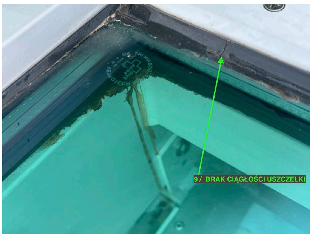
9. Brudny wyciek na połączeniu krzyżowym. Brak ciągłości uszczelki w profilu dociskowym.
