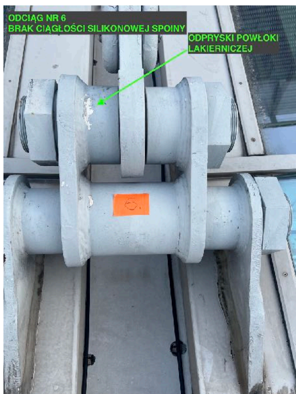
6. Odciąg nr 6: brak ciągłości silikonowej spoiny na połączeniu uchwyty z obróbkami blacharskimi. Odpryski powłoki lakierniczej.
