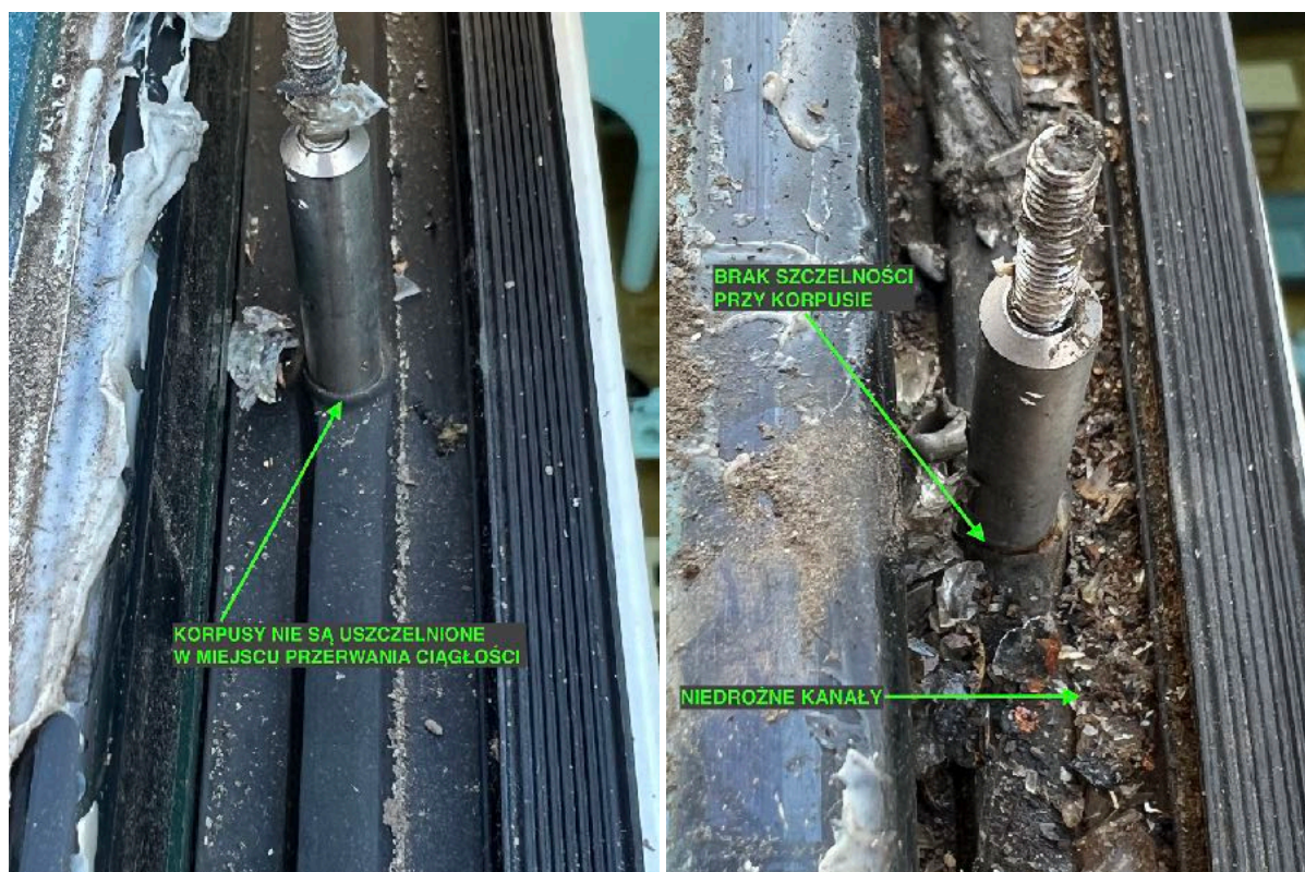
27. W miejscu przebicia uszczelki przez korpus brak szczelności.
