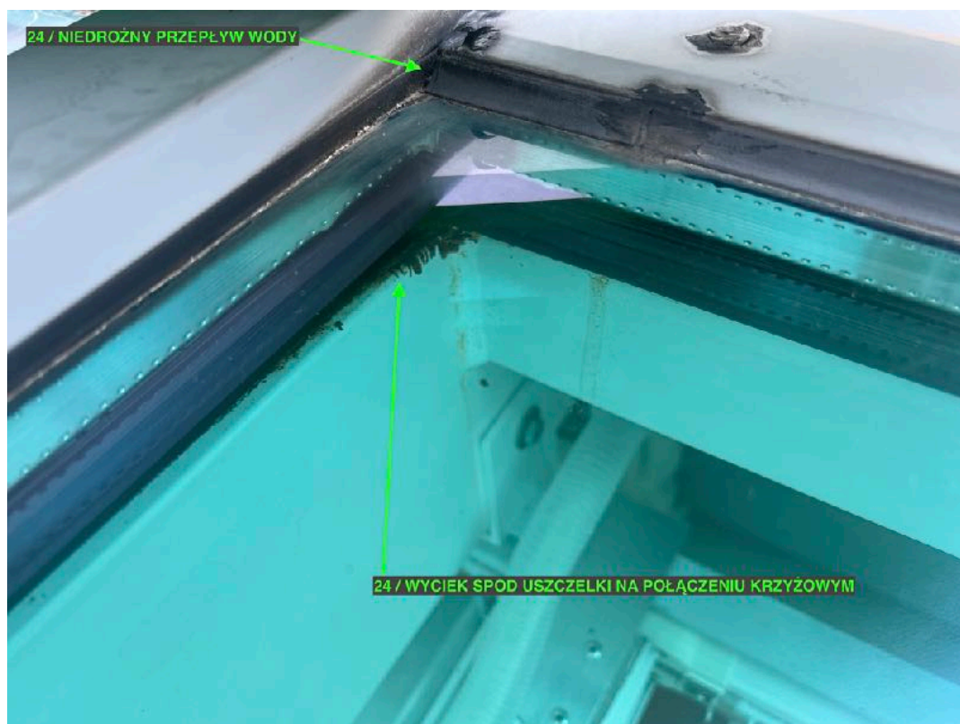
24. Wyciek spod uszczelki na połączeniu krzyżowym. Niedrożny przepływ wody.
