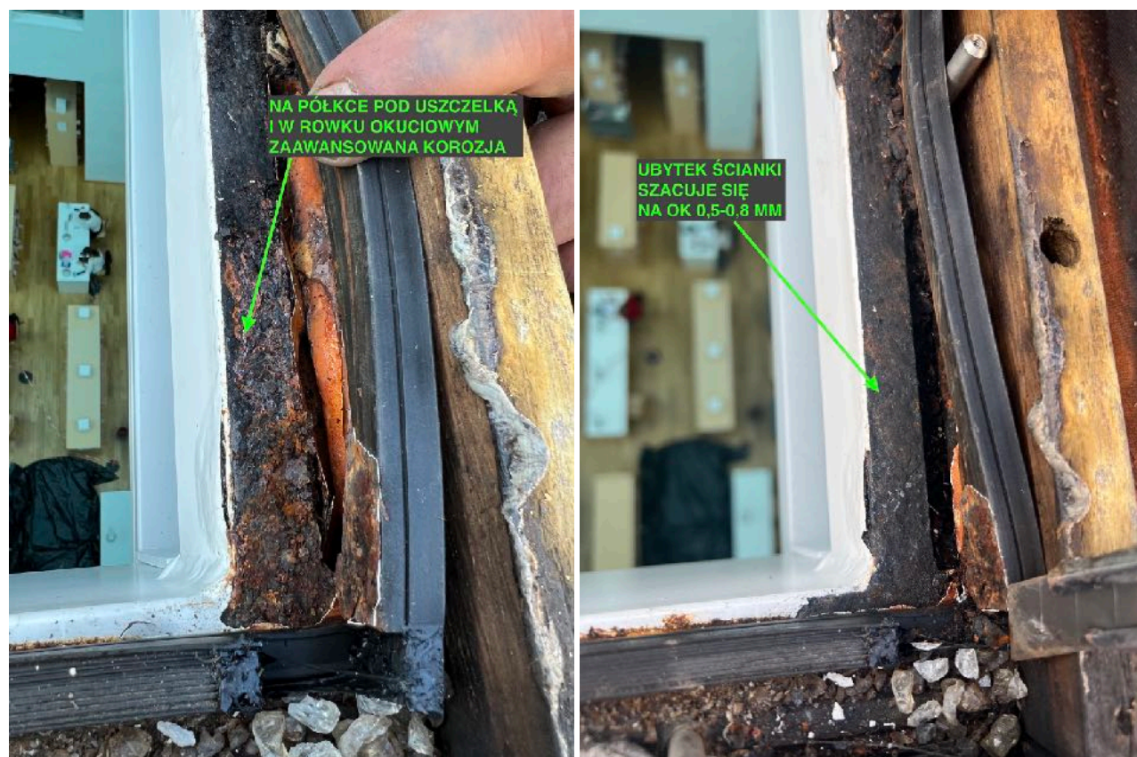
15. Oczyszczono półkę profilu z uszkodzonej powłoki lakierniczej i zeszkrobano produkt korozji. Ocenia się ubytek ścianki na ok 0,5 - 0,8 mm.
