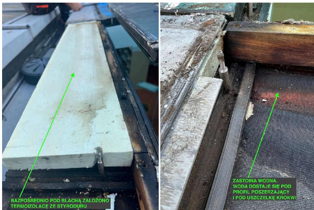
28. Pod obróbką blacharską na krawędzi dachu (przy korycie) zamontowano termoizolację ze styroduru. Pod styrodurem na membranie EPDM wzdłuż profilu płatwi jest zagłębienie w którym gromadzi się woda.
