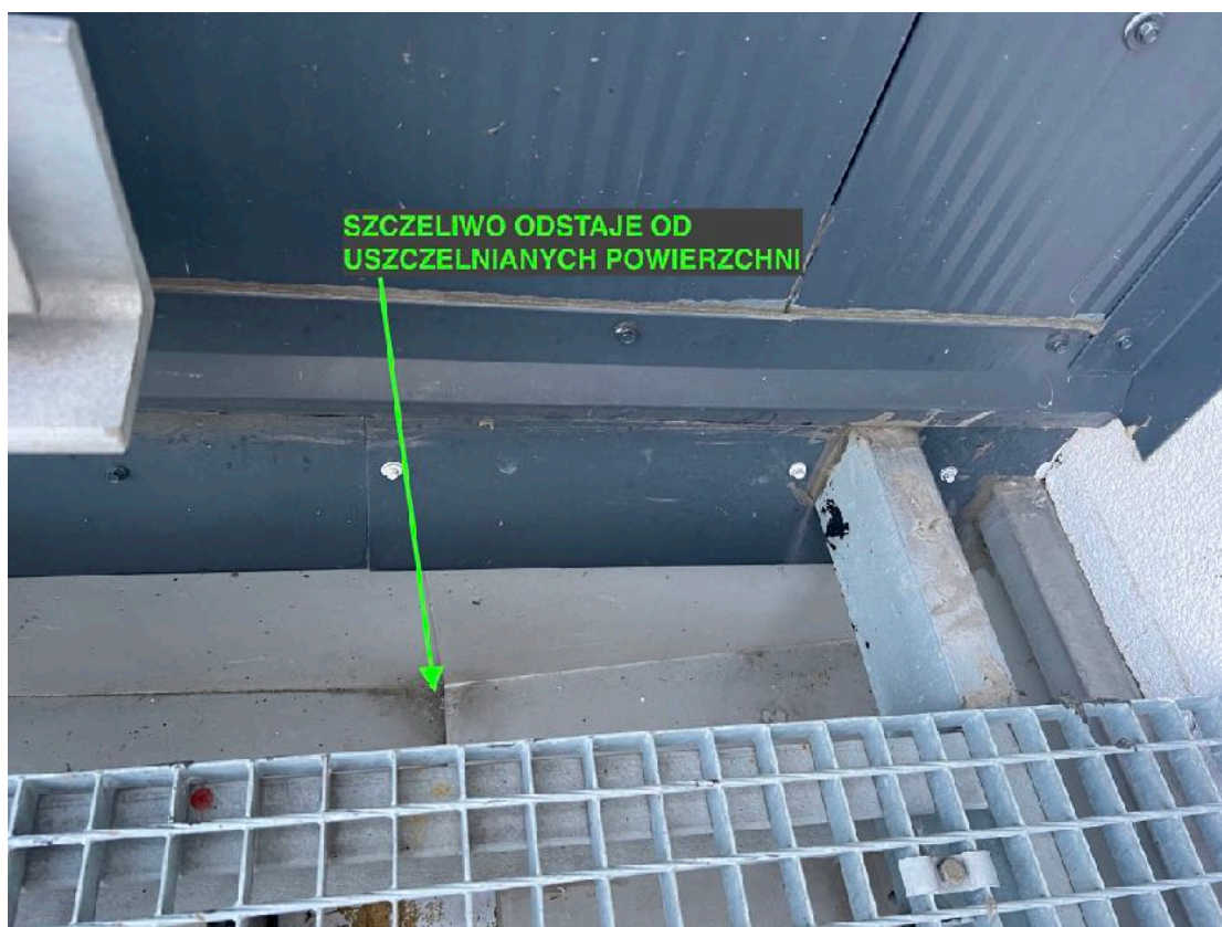
9. Brak ciągłości spoiny na połączeniu obróbek blacharskich.
