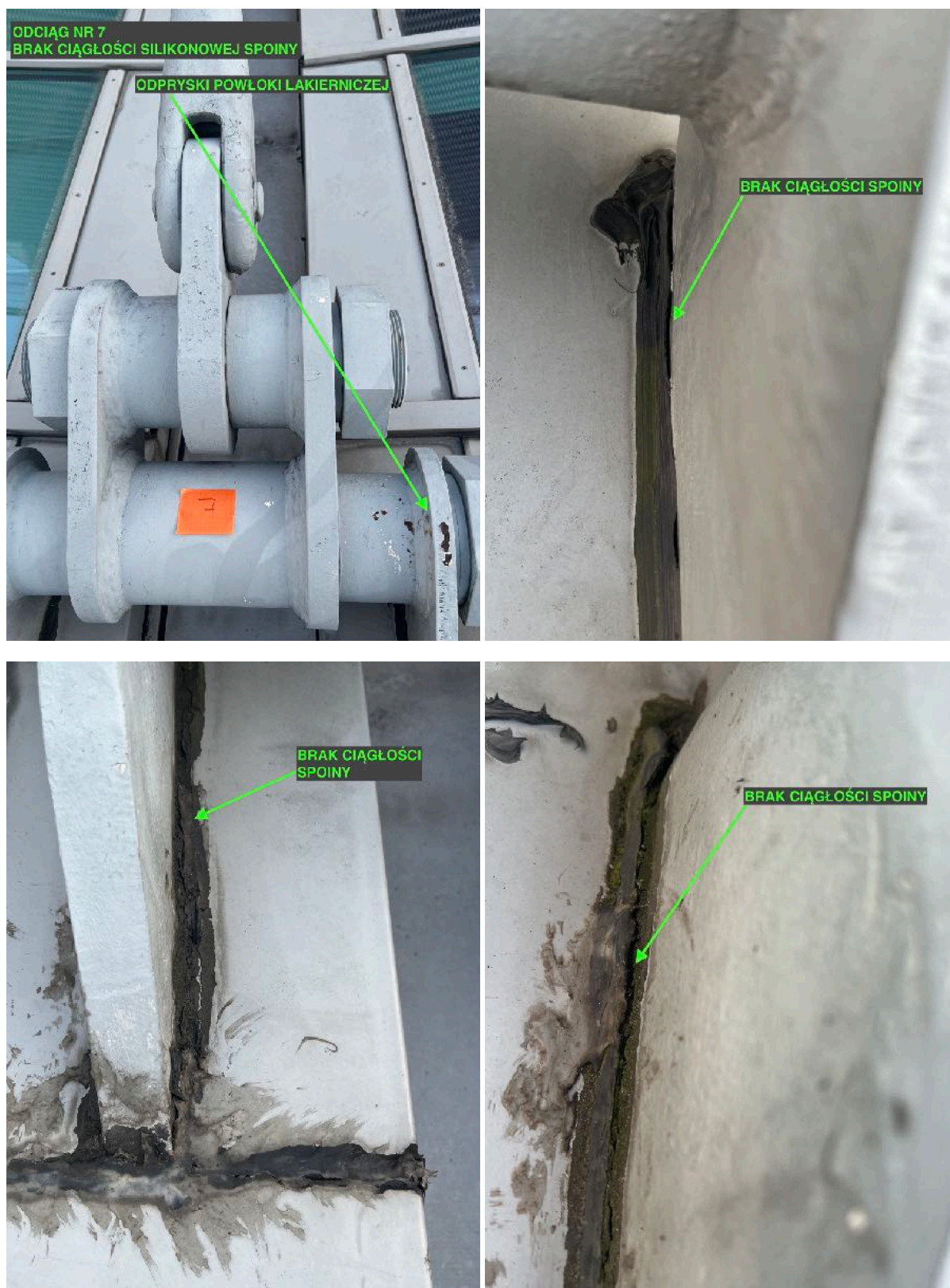
7. Odciąg nr 7: brak ciągłości silikonowej spoiny na połączeniu uchwytów z obróbkami blacharskimi. Odpryski powłoki lakierniczej.
