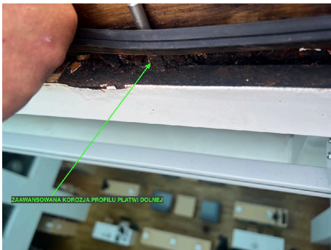
17. Najbardziej zaawansowana korozja występuje w rowku okuciowym przy korpusach.
