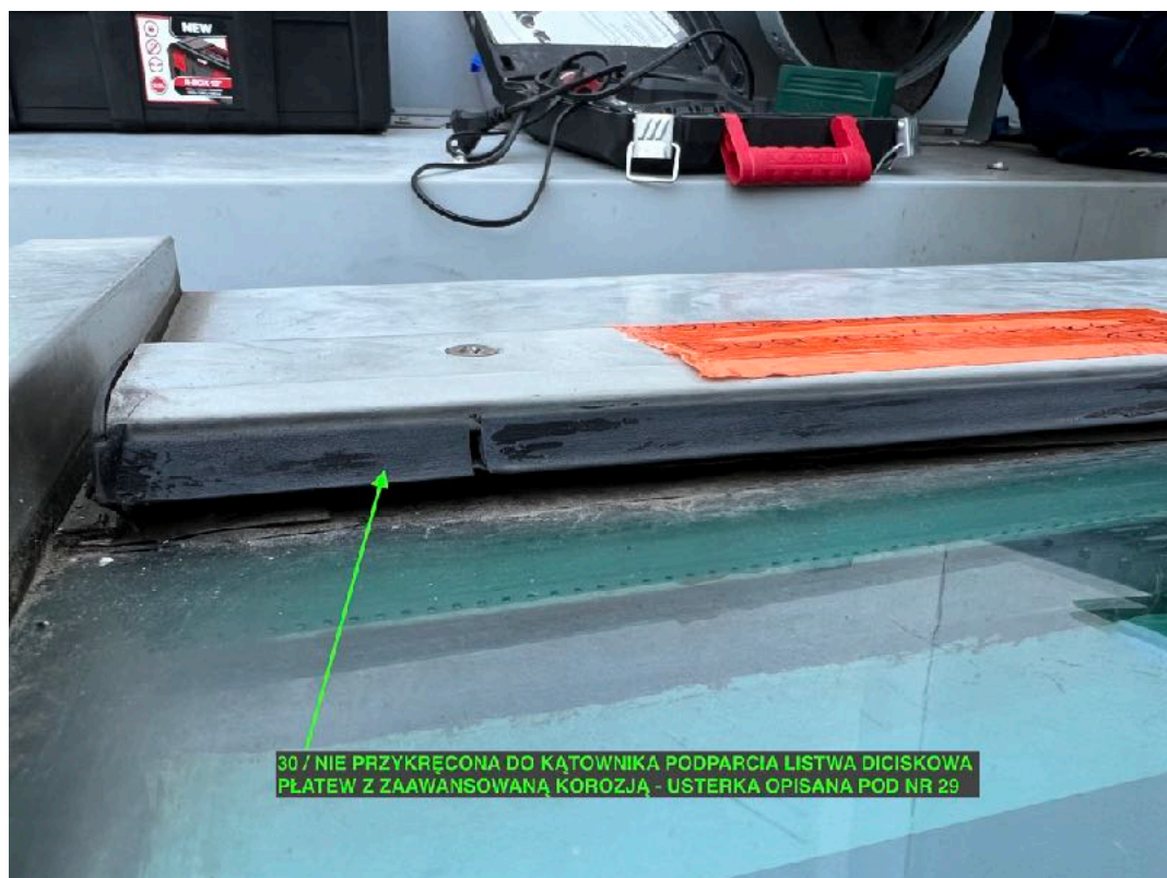
30. Nie przykręcona do kątownika podparcia listwa dociskowa płatwi. Usterka dotyczy nr 29.
