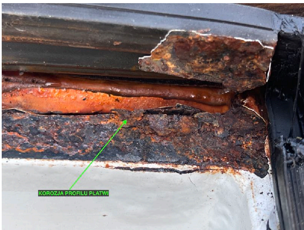
16. Na zdjęciu widać, że korozja występuje na obu półkach i w rowku okuciowym.
