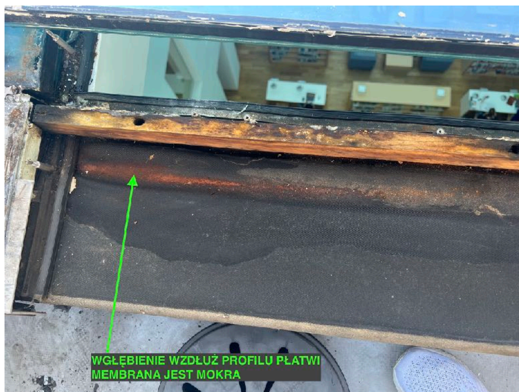
29. Przy połączeniu krzyżowym i wzdłuż profilu płatwi - na membranie EPDM - zastoina wodna.
