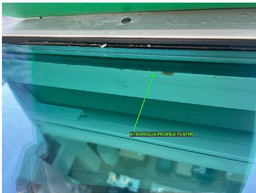
8. Wyciek spod uszczelki. Korozja płatwi.
